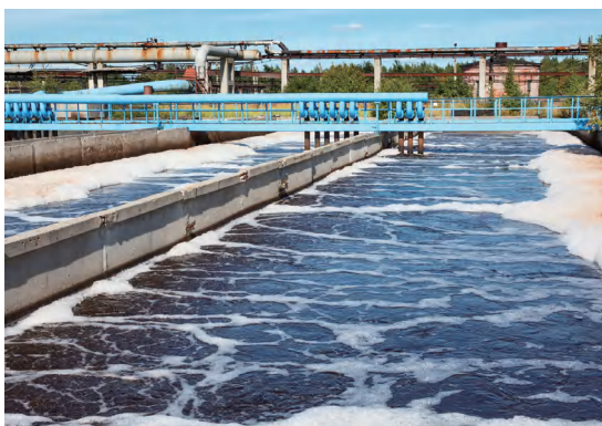
Tratamiento de aguas residuales
